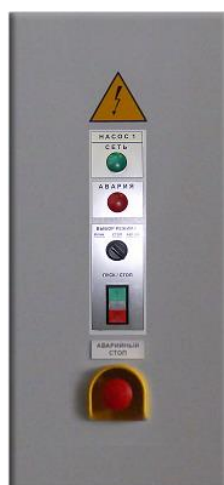
Рис. 7. Выносной пульт ручного управления насосом.
