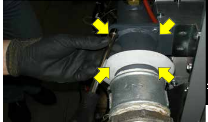
- Достаньте четыре винта при помощи торцевого ключа 10 мм, а затем фланец газа
