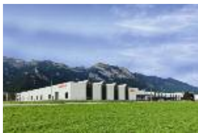
Завод по производству систем, теплоснабжения в Зеннвальде, Швейцария
