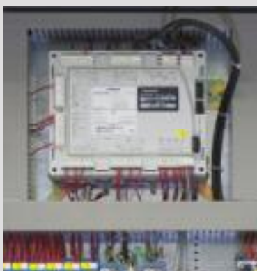
Установка в шкафу управления
