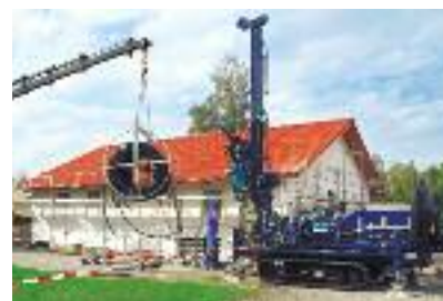
Буровые работы с установкой зонда в грунте специалистами BauGrund Sud
