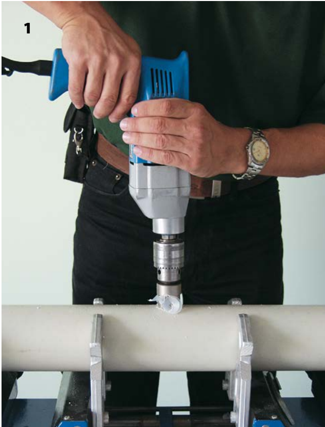
1 Специальной фрезой высверлить отверстие для седла
