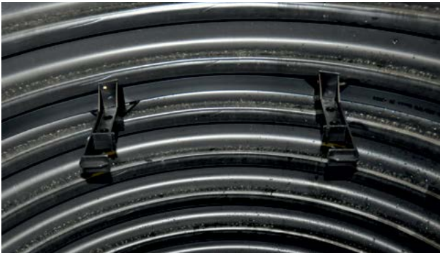
Рис. 6. Предварительный монтаж держателя лестницы в шахтной трубе.
