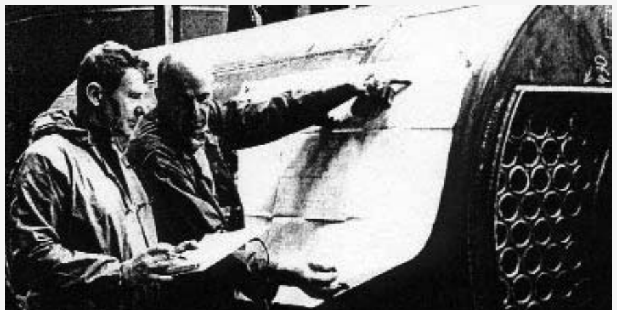
Проверка соответствия котла Viatomax технической документации
