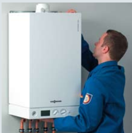
2. Закрепите котел на стене
