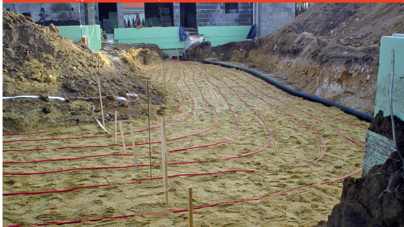
Рис. А.4.1–2 Грунтовый коллектор
