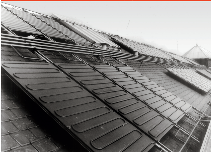
Рис. А.4.6–1 Источник тепла - неостекленные абсорберы
