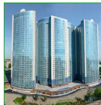
Санкт-Петербург ЖК «Невский»
