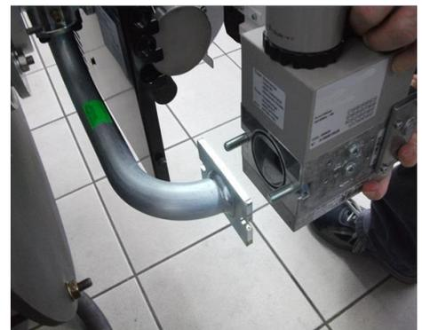
9) установить электроклапан на Труба ГАЗОВОЙ рампы;
