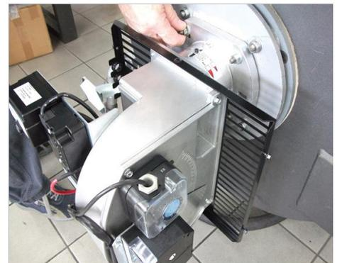
6) Зафиксировать горелки на котел;
