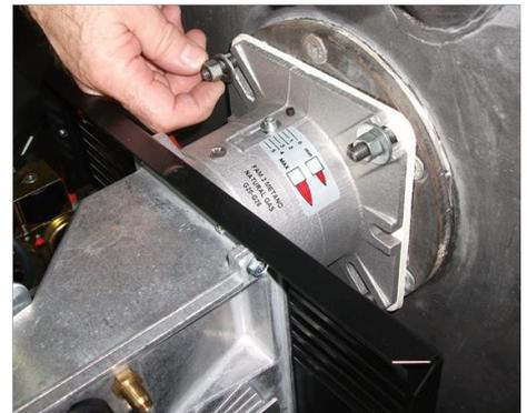
6) Зафиксировать горелки на котел;
