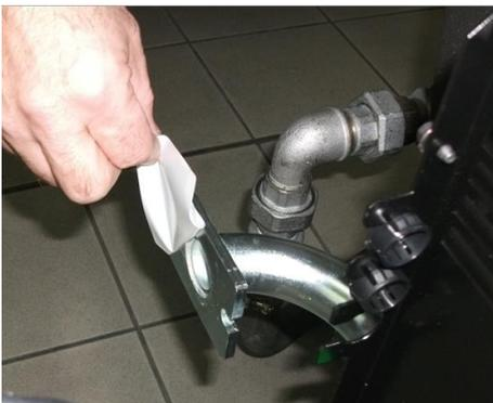
7) Снять заглушку из Труба ГАЗОВОЙ рампы;
