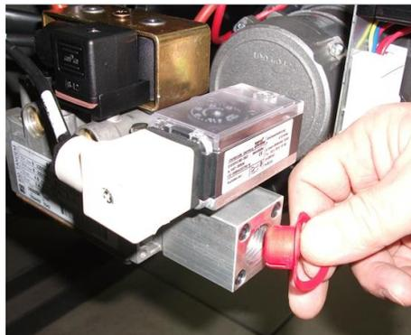
8) Снять заглушку из Труба ГАЗОВОЙ рампы;
