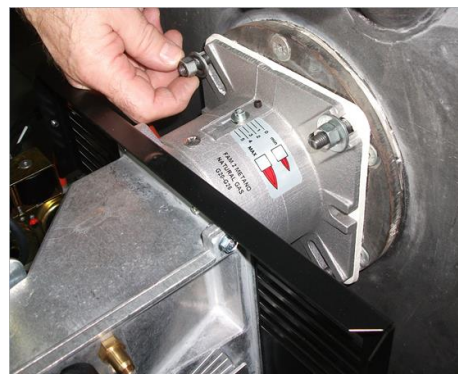
6) Зафиксировать горелки на котел;
