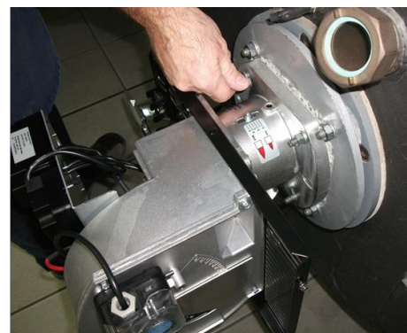
6) Зафиксировать горелки на котел;
