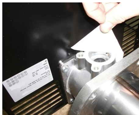
2) повернуть Горелка и Снять заглушку;
