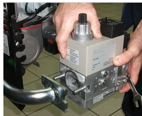
9) установить электроклапан на Труба ГАЗОВОЙ рампы;
