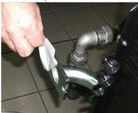
7) Снять заглушку из Труба ГАЗОВОЙ рампы;
