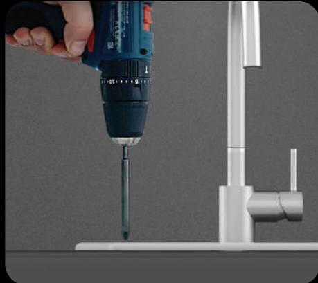
Просверлите отверстие под кран для чистой воды при помощи сверла, диаметром 12 мм.
