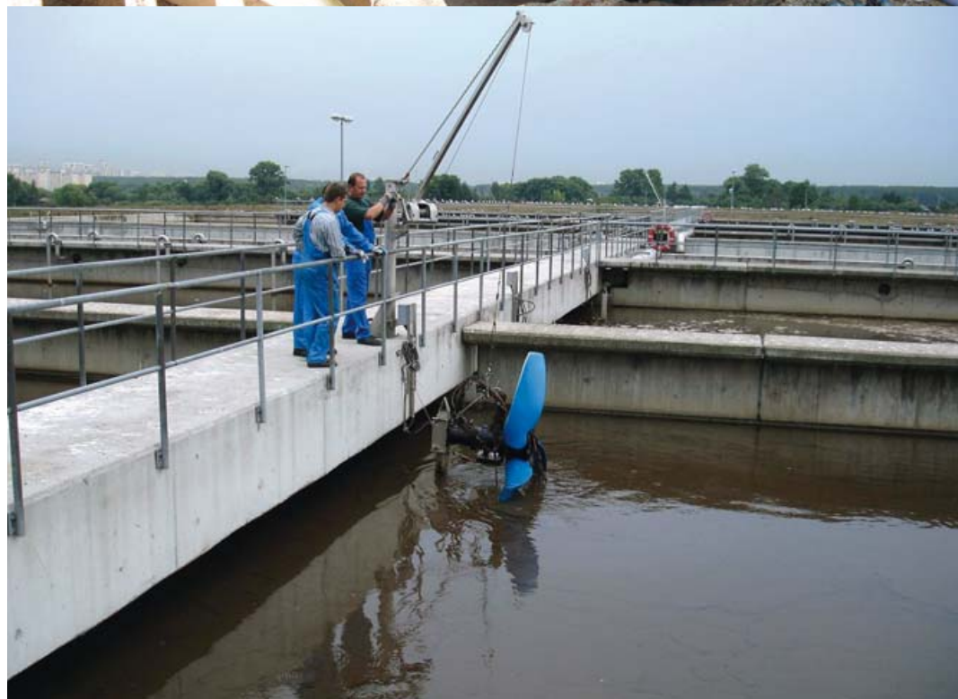
Очистительная канализационная станция Южное Бутово в Москве.
