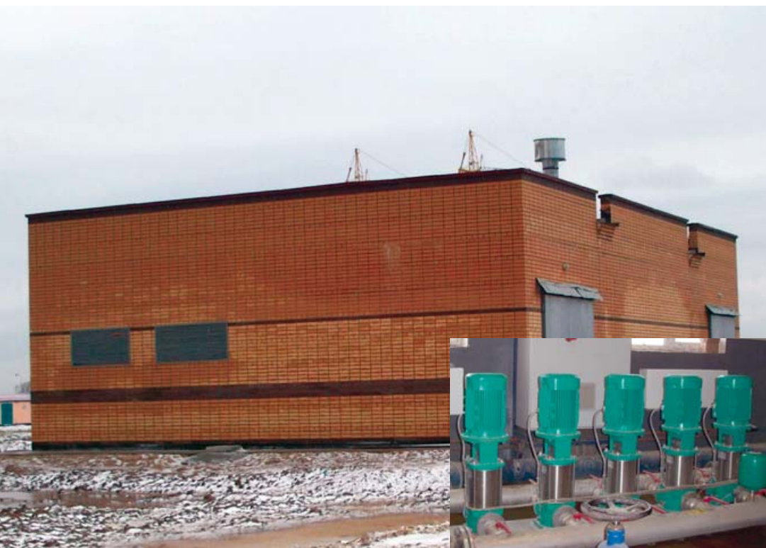
Насосная станция микрорайон «Бусилово» в Твери.
