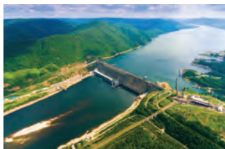
Красноярская ГЭС, г. Дивногорск
