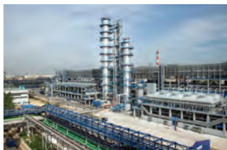
Газпромнефть-МНПЗ, г. Москва
