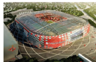
Футбольный стадион «Открытие Арена», г. Москва
