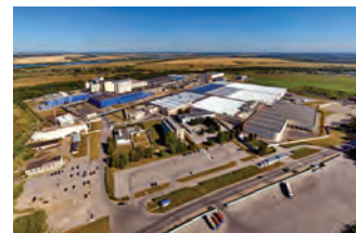
Завод «Проктер энд Гэмбл», г. Новомосковск
