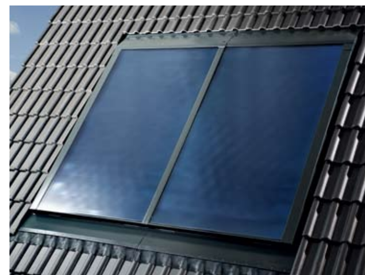
Интеграция солнечных коллекторов в поверхность кровли
