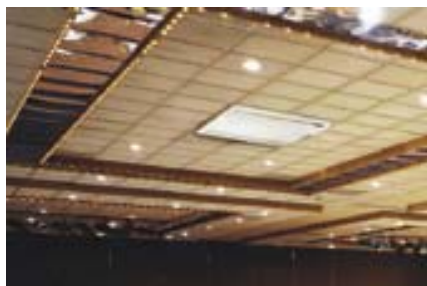
Установка на потолке
