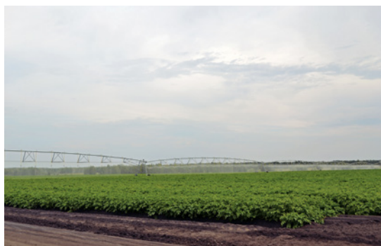
Строительство систем орошения для КФХ КНЫШ А.А. Омская обл., 2022 г.
