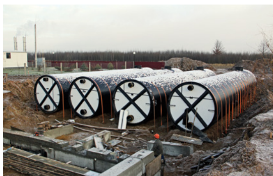
Реконструкция здания утильного цеха и цеха убоя птицы ЗАО «ЮНИМИТ» Беларусь, пос. Октябрьский, 2018 г.
