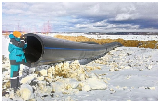
Строительство «Епанчинского водозабора». Комплекс «ЗапСибНефтехим», г. Тобольск
