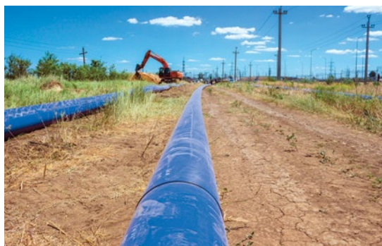
Строительство канализационного коллектора от п. Гумрак до г. Волгоград
