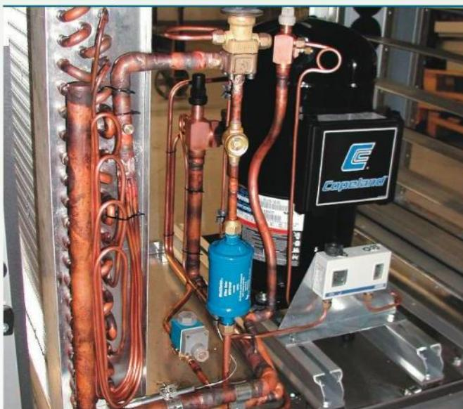
Холодильный контур теплового насоса герметичен, работает на экологически безопасном фреоне R407C.
