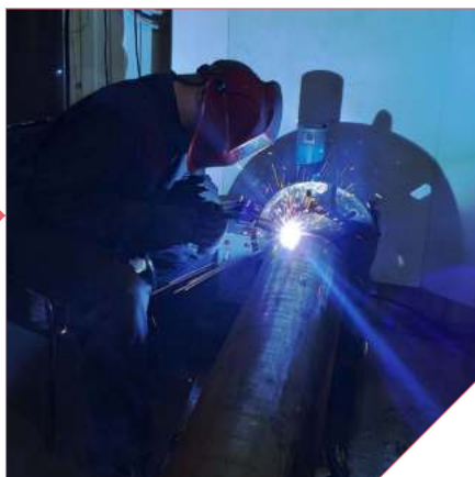
СВАРКА В СВАРОЧНОМ ВРАЩАТЕЛЕ
