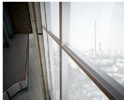
**Конвектор фасадный с отсеком для труб**
