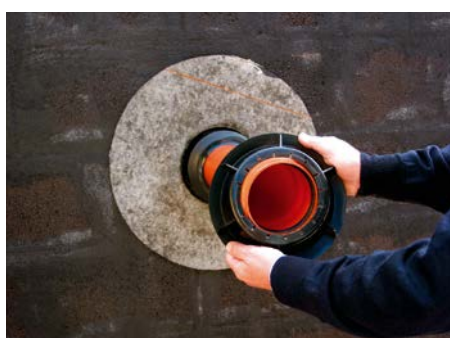
4. Установить фиксирующую гайку
