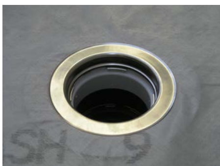
10. Зажать фильтрующий слой фиксирующим фланцем элемента HL350.0
