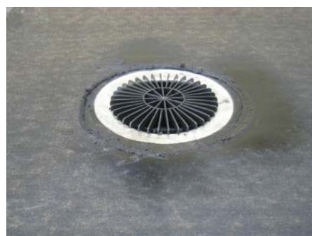
5. Так должна выглядеть воронка после укладки гидроизоляции
