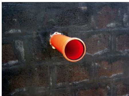
1. Труба проведена через стену с битумным покрытием.
