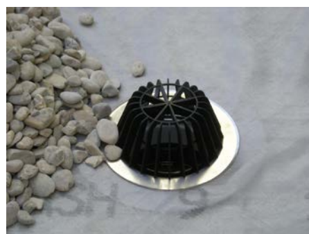
11. Установить листоуловитель, выполнить засыпку гравием (фракция: 20÷40 мм)
