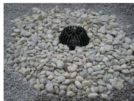
12. Засыпать гравием остальную поверхность кровли
