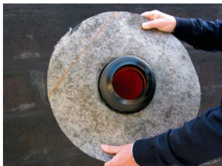
2. Надеть гидроизоляционную мембрану
