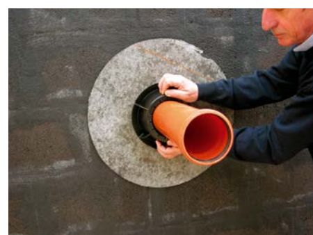
6. Затянуть фиксирующую гайку
