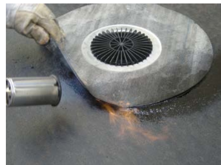
3. Приварить полимербитумное полотно воронки
