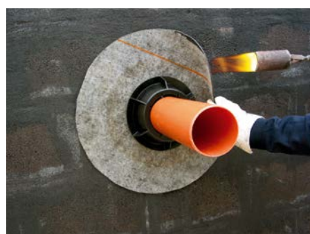
5. Приварить мембрану к битумному покрытию стены
