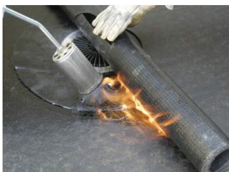
4. Наклеить 2-й слой гидроизоляции (до обжимного фланца)
