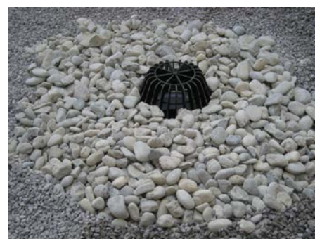
12. Засыпать гравием остальную поверхность кровли
