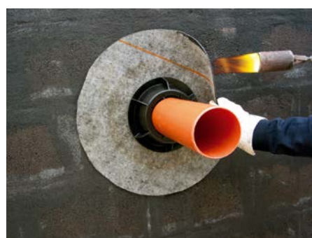
5. Приварить мембрану к битумному покрытию стены
