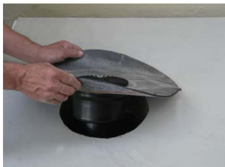
1. Прodelать отверстие, закрепить воронку HL62H
