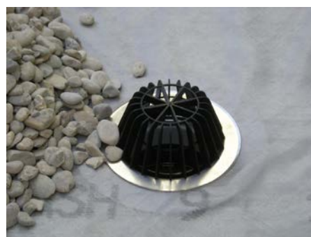
11. Установить листоуловитель, выполнить засыпку гравием (фракция: 20÷40 мм)
