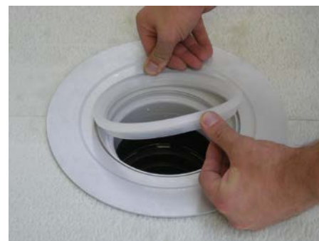
9. Убедиться в правильности установки прозрачного пластикового кольца
