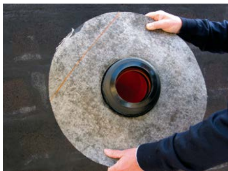
2. Надеть гидроизоляционную мембрану
