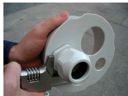
3. Установить и зафиксировать кабельные вводы.
