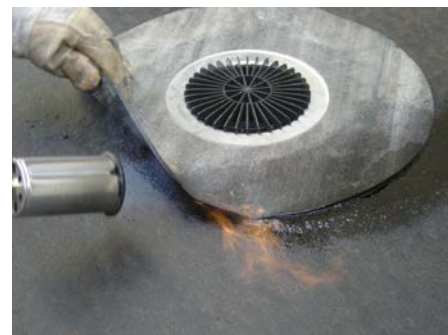
3. Приварить полимербитумное полотно воронки
