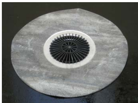
2. Нанести праймер, наклеить 1-й слой гидроизоляции
