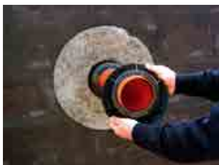
4. Установить фиксирующую гайку
