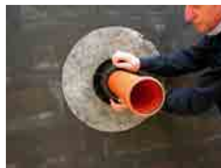
6. Затянуть фиксирующую гайку
