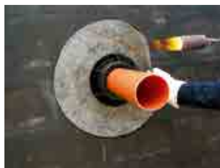
5. Приварить мембрану к битумному покрытию стены
