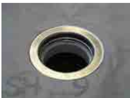
10. Зажать фильтрующий слой фиксирующим фланцем элемента HL350.0
