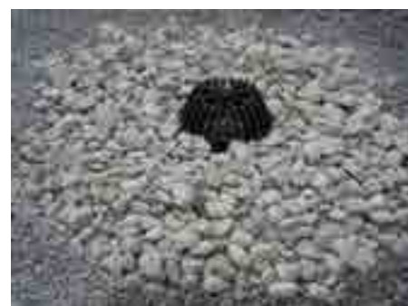
12. Засыпать гравием остальную поверхность кровли
