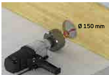
1. Пробурить отверстие Ø 150 мм или проделать отверстие 150 x 150 мм
