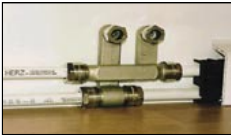
Рис. 10.4.а Вариант плintусной разводки для двухтрубной системы отопления
