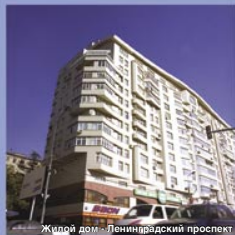
Жилой дом - Ленинградский проспект
