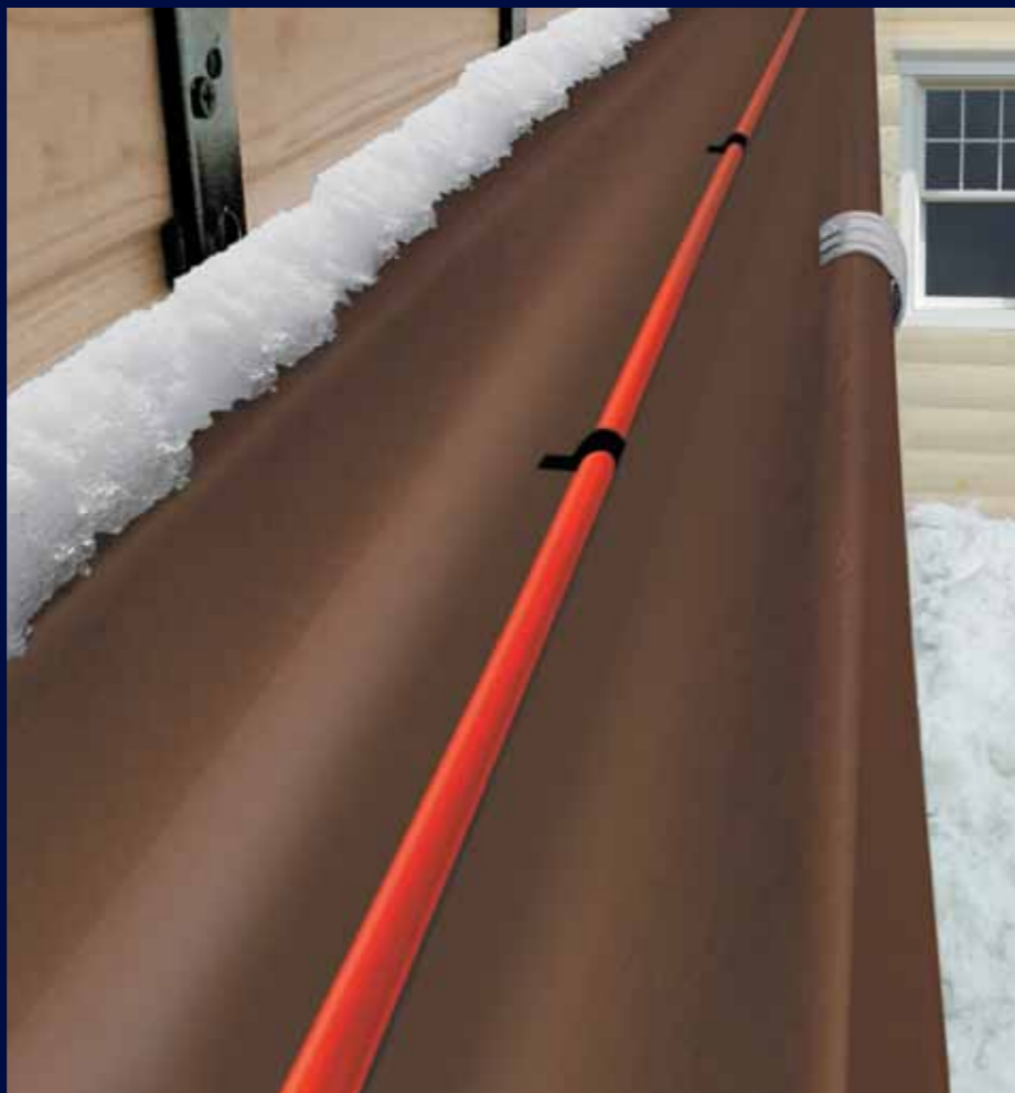
Вариант установки нагревательного кабеля в водосточных желобах
