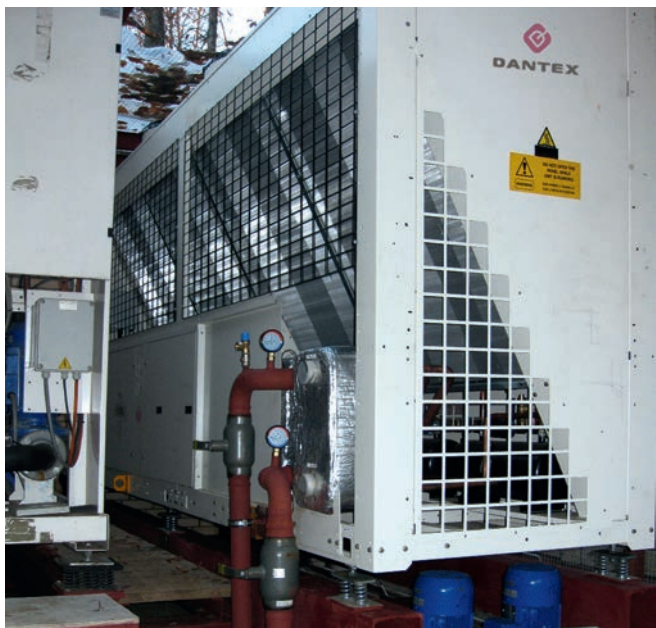
Замок "Майн Дорф" - Резиденция Президента РФ Московская область (Россия) Чиллеры с воздушным охлаждением конденсатора Dantex
