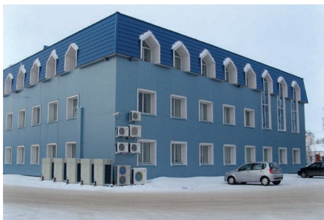
Офисный центр г. Сыктывкар Мультизональные системы Dantex
