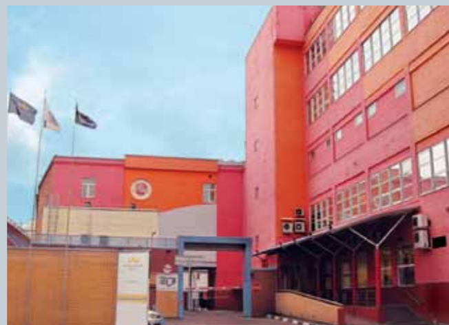
Табачная фабрика ОАО «БАТ-Ява» (г. Москва)
