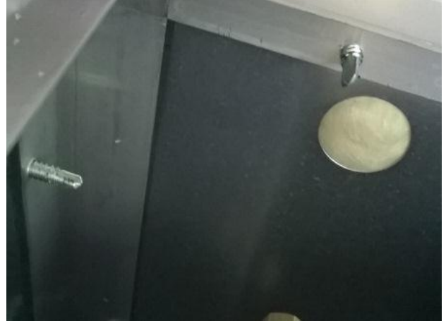
Конкуренты: крепеж саморезами со сверлом
