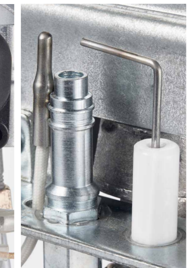
Защитная термопара для контроля пламени
