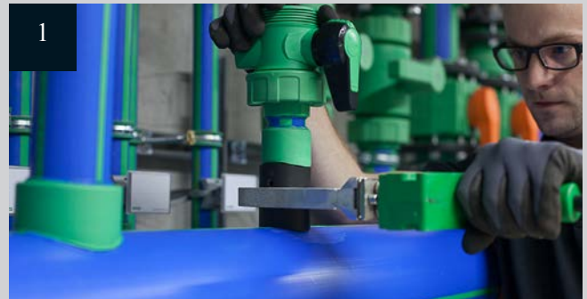
Приварка наварного седла на главную трубу
