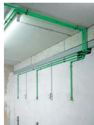
Монтаж на штукатурку
