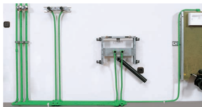
Монтаж на стене
