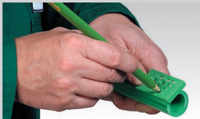
Отметка глубины сварки
