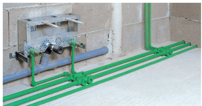
Распределительный блок для водоснабжения
