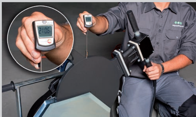
Измерение температуры на сварочной машине aquatherm для сварки встык
