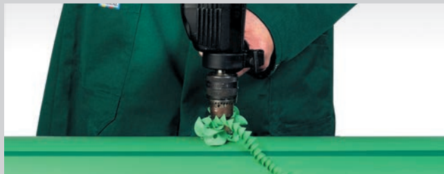
Сверление отверстия в стенке трубы
