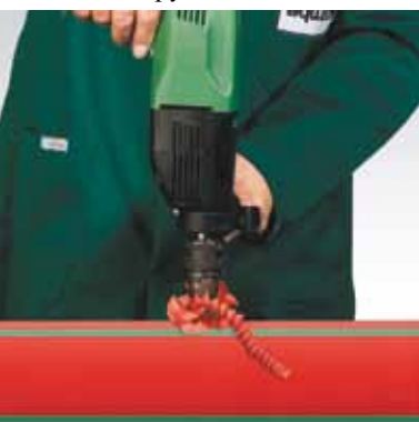
Просверливание отверстия в стенке трубы.
