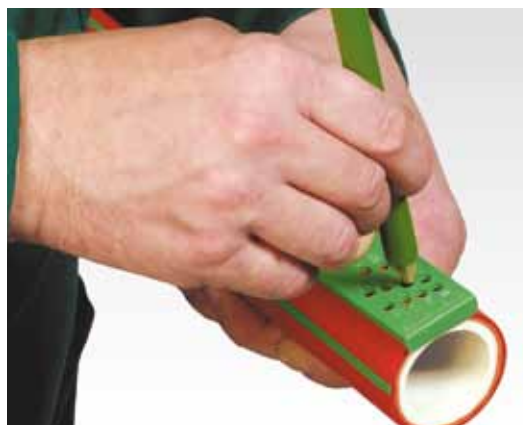
Отметка глубины сварки.
