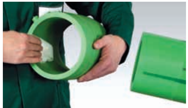
Чистка внутренней поверхности электромуфты
