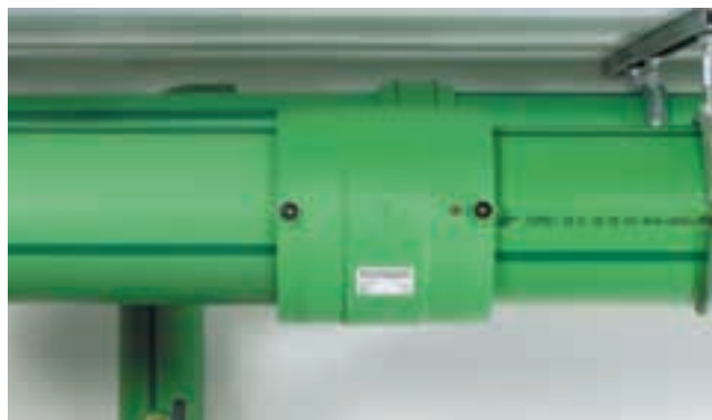
Насаживание второй, также очищенной и зачищенной трубы в муфту
