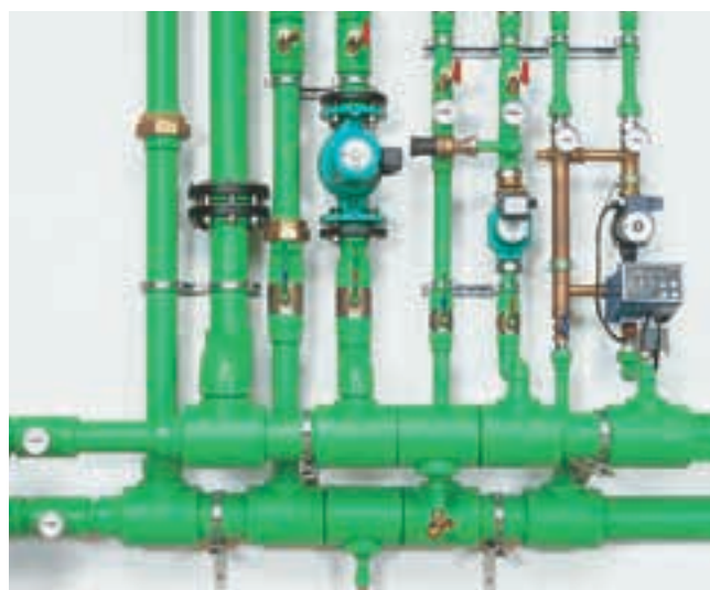
Распределитель в системе отопления
