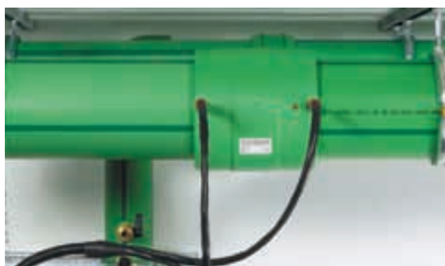
Сварочный аппарат настроить под диаметр муфты. Начать процесс сварки. Выдержать время охлаждения. Готово!
