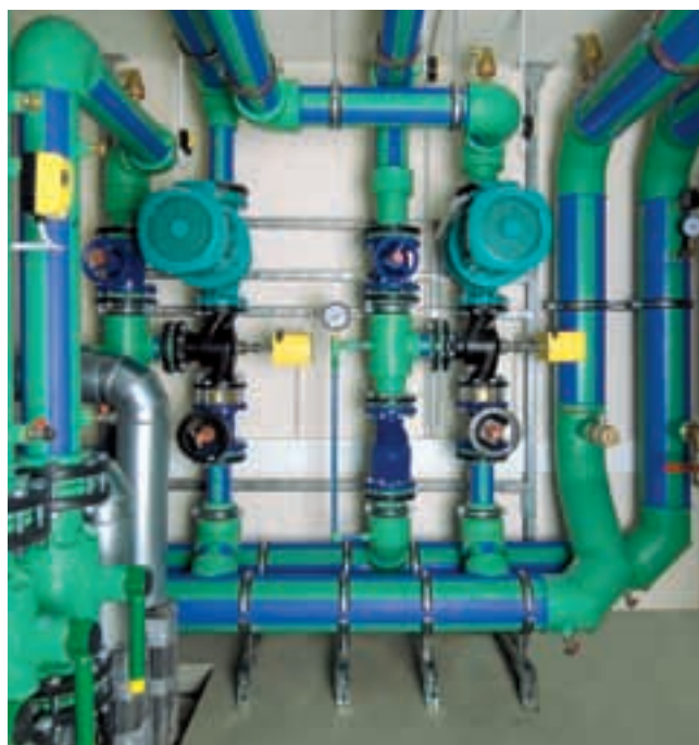
Монтаж распределителя из комбинированных труб fusiotherm® и climatherm Faser и большого шарового крана
