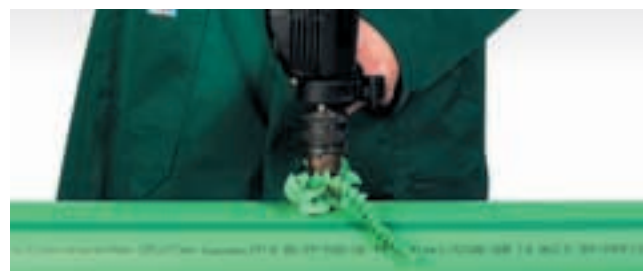
Просверливание отверстия в стенке трубы
