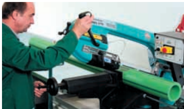
Перед сваркой отрезать трубу на желаемую длину
