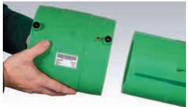
Насаживание электромуфты на зачищенный край трубы
