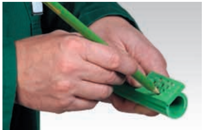
Отметка глубины сварки
