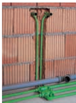
Монтаж под штукатурку
