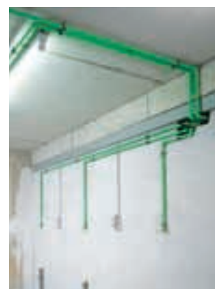
Монтаж на штукатурку
