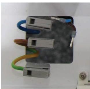
3. Не перекручивая жилы кабеля, расположите клеммники так, чтобы они не мешали установке крышки разъема электроподключения.
