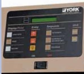
Машины TEMPO оборудованы микропроцессорным контроллером с жидкокристаллическим дисплеем на 40 символов, на котором отображаются температуры, давления, часы наработки, число пусков, расписание пусков/ остановов на рабочие и выходные дни. Функции регулирования включают в себя точное поддержание температуры жидкости на выходе, согласование работы основного/ подчиненного компрессоров, управление работой устройств защиты контуров циркуляции.
