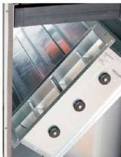
Проверить клапаны на легкость хода. Не смазывать клапаны. Используемый синтетический материал может от этого разрушиться, и клапан перестанет функционировать.
