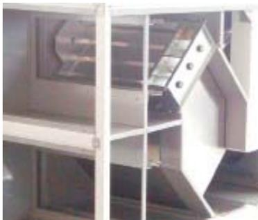
Противоточный пластинчатый теплообменник принципиально не требует технического обслуживания.
