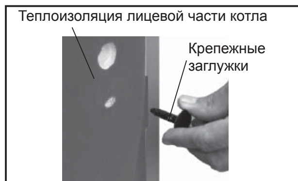
Рис.: Теплоизоляция лицевой части котла
