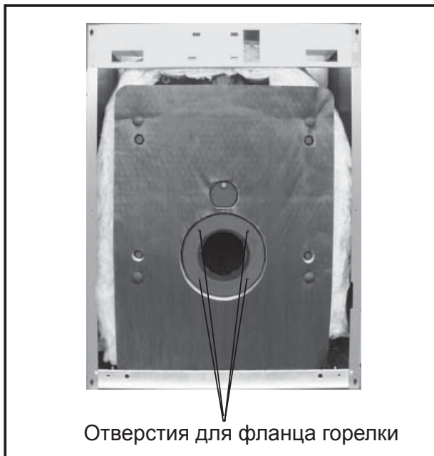
Рис.: Фланец котла
