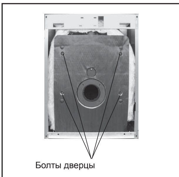
Рис.: Демонтаж дверцы котла
