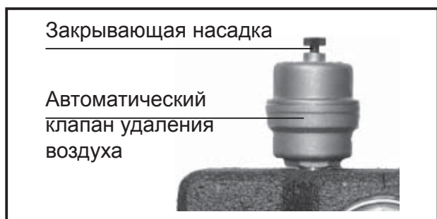
Рис.: Автоматический клапан удаления воздуха
