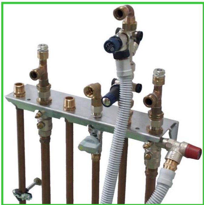
Консоль для труб при установке сверху штукатурки
