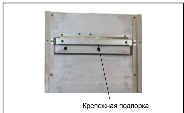
Рис.: Подпорка на газовом настенном котле
