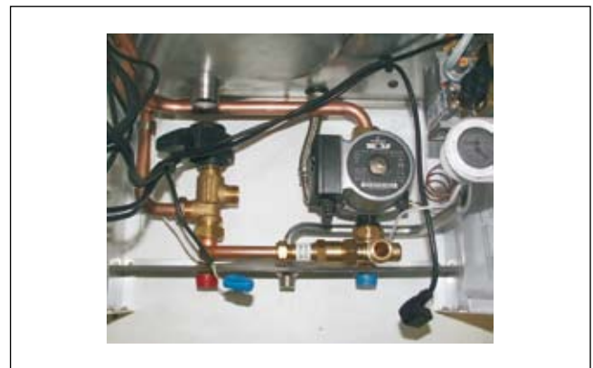
Рис.: Блок подключения демонтирован
