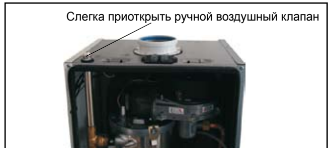
Рис.: Воздушный клапан с ручным управлением
