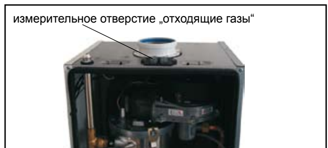
Рис.: Измерение отходящих газов на открытом котле
