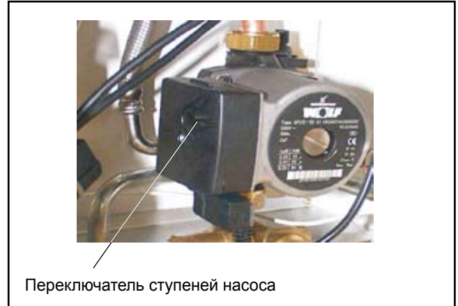
Рис: Переключатель ступеней на насосе котлового контура
