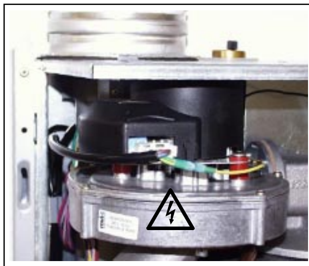
Рис.: Штекер вентилятора: опасность от электрического напряжения
