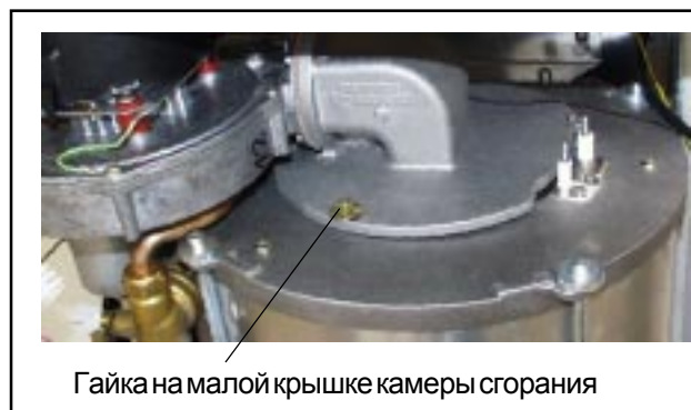
Рис.: Гайка на крышке камеры сгорания
