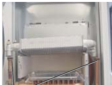
Рис: Демонтаж теплообменника сетевой воды
