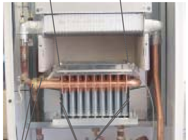
Крепежные болты Компоненты горелки [2]
