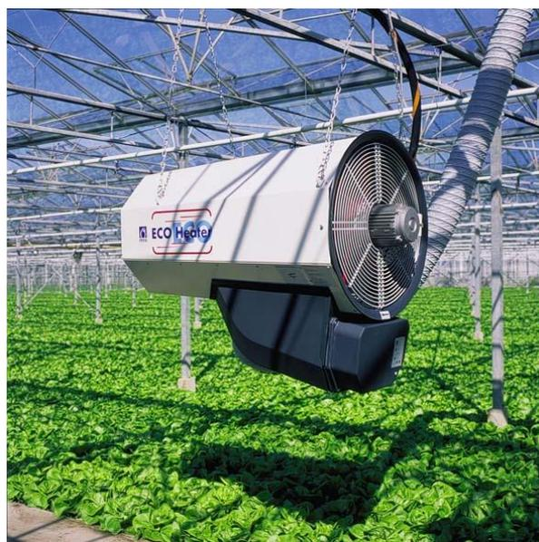
Забор чистого насыщенного кислородом воздуха на горение с улицы обеспечивает чистое горение и надёжную работу воздухонагревателя. Агрегаты легко монтируются, простая конструкция обеспечивает удобный доступ для чистки при обслуживании. Безопасная работа обеспечивается автоматическим контролем пламени, в процессе работы все функции контролируются встроенным блоком управления.
