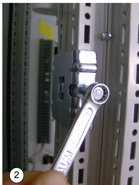
Монтаж стягивающего соединителя на вертикальных профилях шкафа
