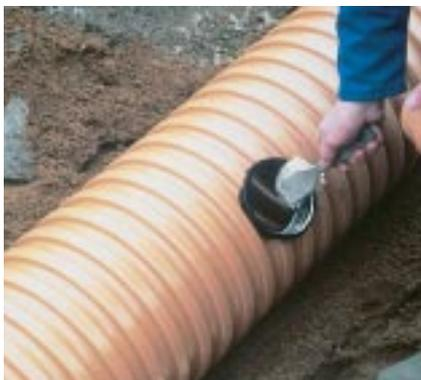
На внутреннюю поверхность уплотнения наносится силиконовая смазка, после чего вставляется пластиковая муфта перехода «In Situ» (2-3).
