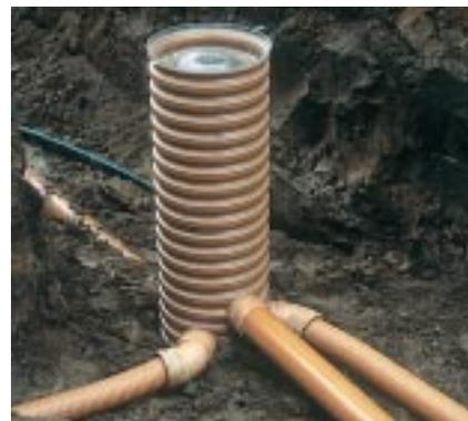
Трубы, укладываемые вокруг здания для дренажа, обычно присоединяют к одному общему колодцу
