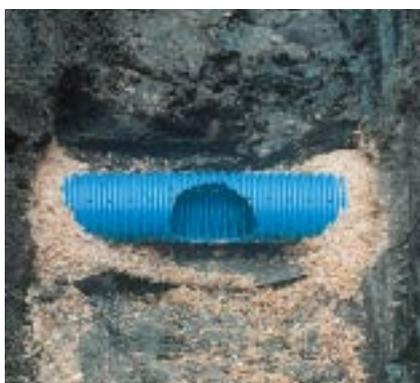
Для выполнения отвода от существующей дренажной трубы откопайте нужный участок и вырежьте отверстие обычным ножом
