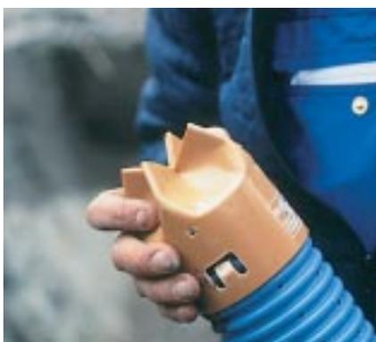
Концевая заглушка устанавливается так же, как и муфта (7).
