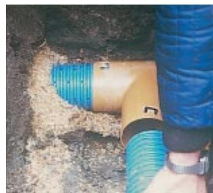
Нажмите на ответвитель до полной фиксации его на трубе, проверьте правильность расположения относительно отверстия
