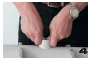
4 Нагретое седло всунуть в нагретое отверстие и зафиксировать примерно на 16 с. Через час систему можно заполнить водой и нагрузить давлением.
