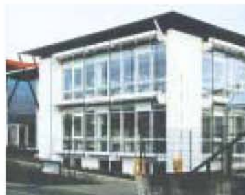
Индустриально-офисное здание в г.Штайнен. 610 кв.м теплых полов Art therm.
