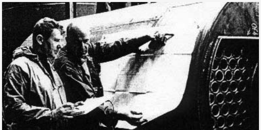
Проверка соответствия котла Viatomax технической документации
