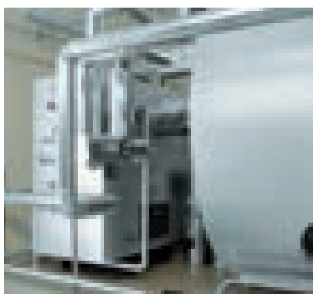
Vitomax 200-HS с отдельно стоящим экономайзером
