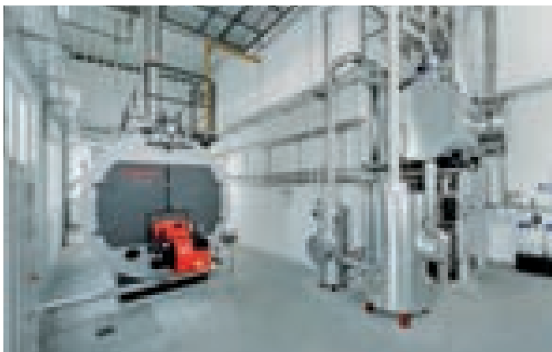
Vitomax 200-HS, 4 т/ч, 16 бар StoVerotec, Германия
