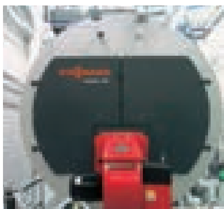
Vitomax 200-NS паропроизводительностью 10 т/ч, 13 бар Молочный завод в Люцерне, Швейцария
