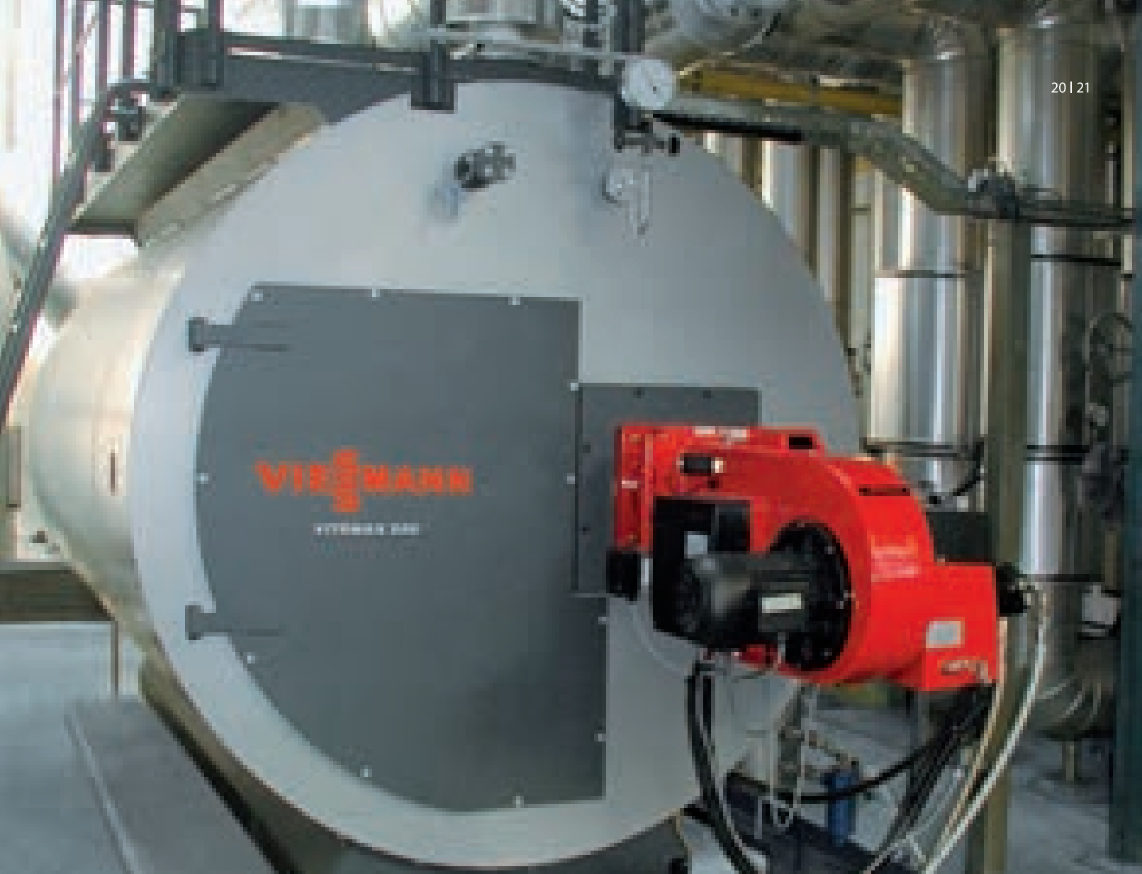
Паровой котел Vitomax 200-HS
