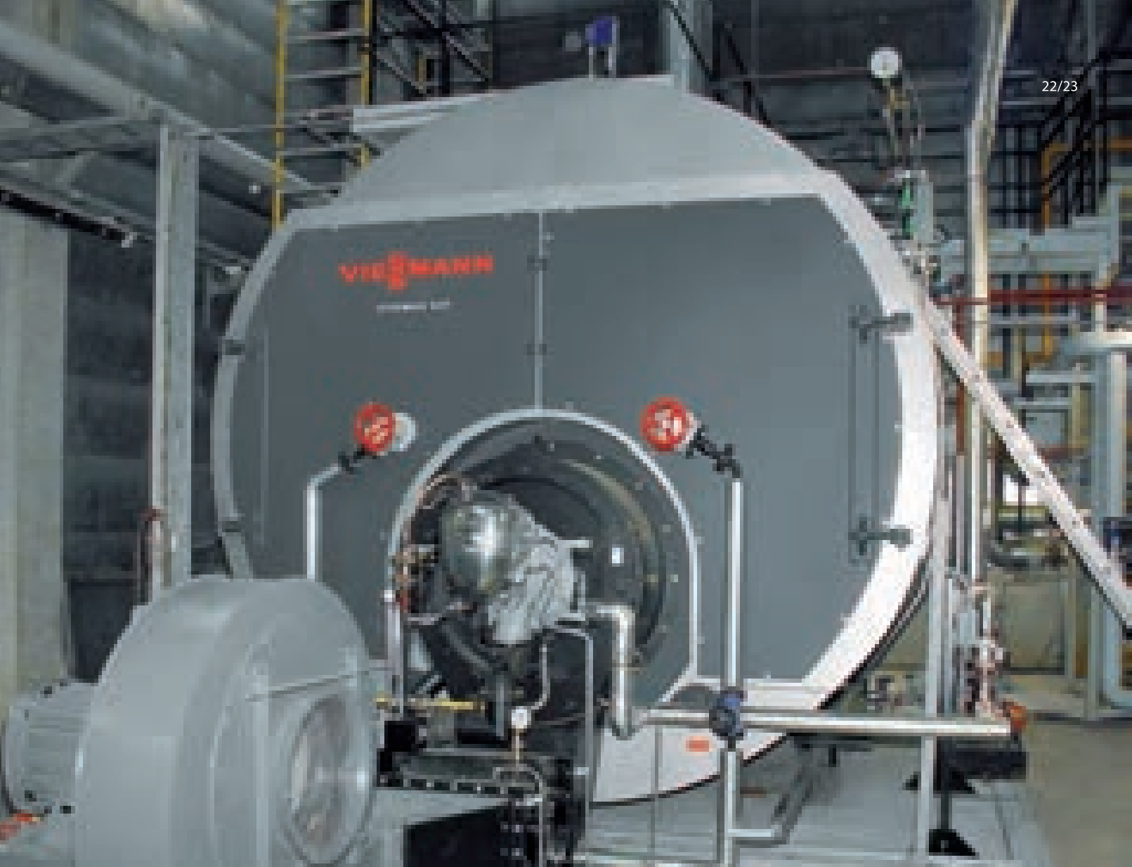
Паровой котел Vitomax 200-HS с горелкой для сжигания животного жира
